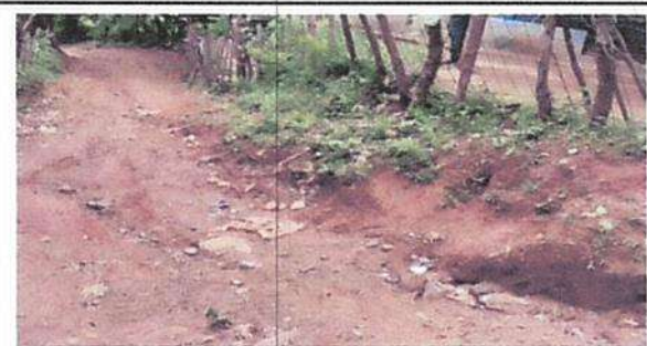
Foto 5: como se puede observar la escuela se encuentra en una pendiente, para evitar que la tierra se derrumbe se necesita un cerramiento con muro perimetral
