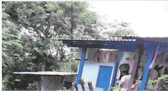
Foto 1: Como se puede observar las aulas no cuenta con bajas de agua pluvial
